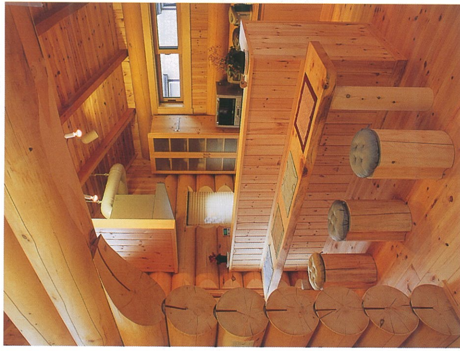
キッチンの軒側を広く使えるように、急ぎよドーマーをつけることに。細長い窓を取り付け、明るさも確保。喫茶店のような木製カウンターが家の雰囲気にピッタリ
