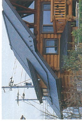
左/二重にしている屋根はちょうど躯体の上の部分だけにして、費用も抑えている。右/北側ドーマーは、洗面所とトイレ。少しでも壁が高く、窓がある、明るさと広さが全然違う
